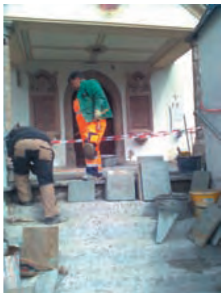
Die westl. Kirchstiege wurde saniert.
