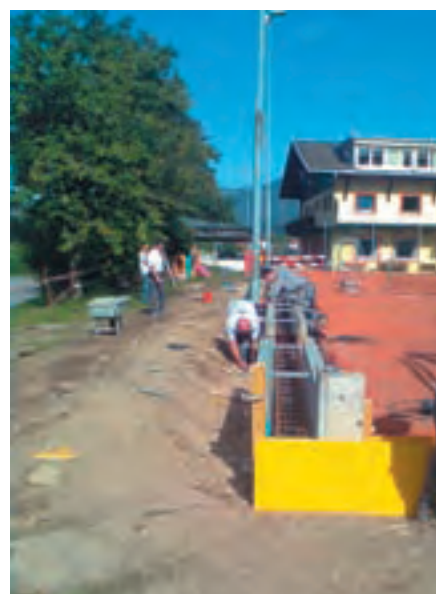
Beim Sportzentrum wurde der Tennisplatz Nr. 4 saniert (Fundamentmauer und Zaun)
