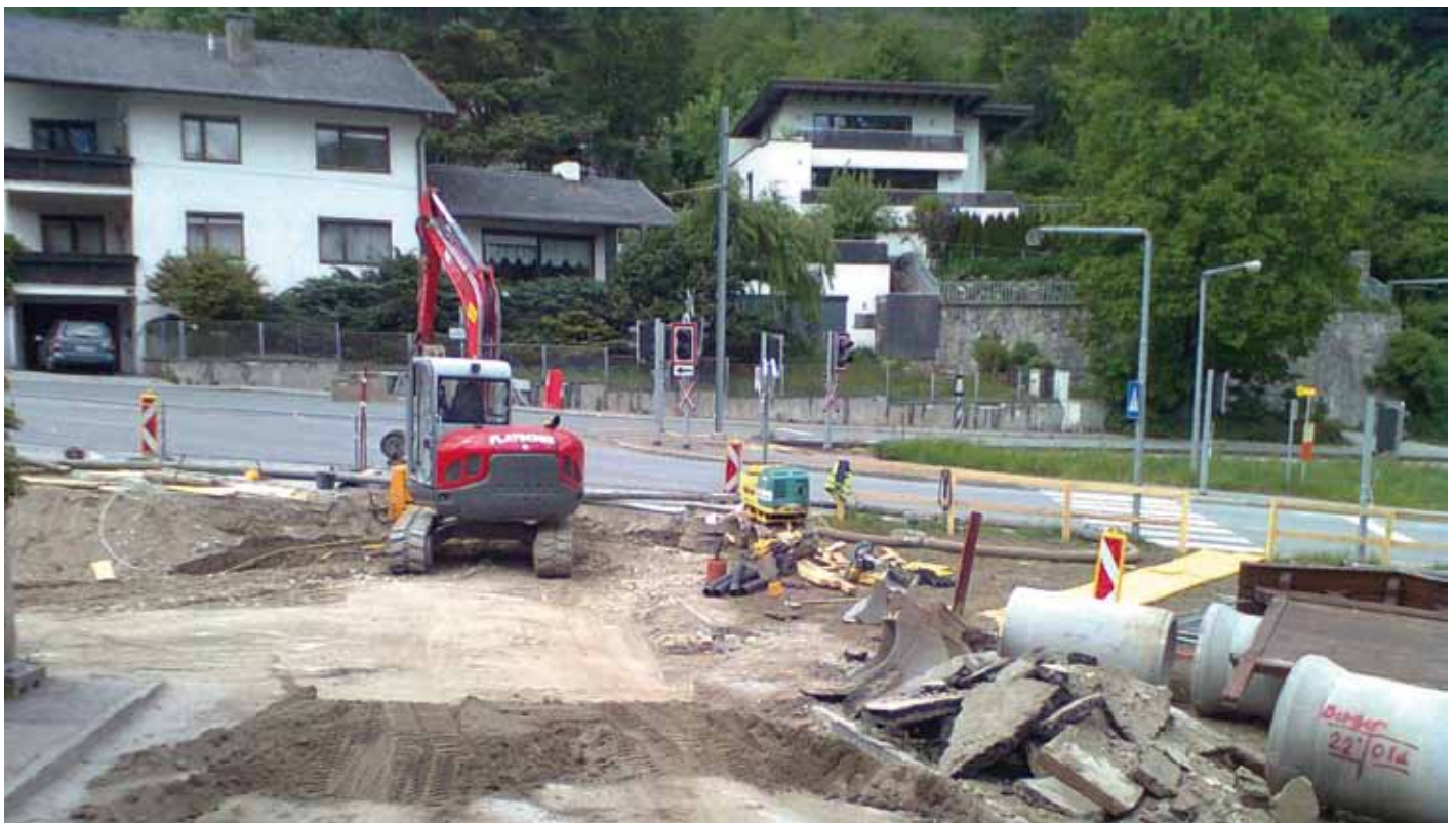
Baustelle „Hochwasserverbauung Koflers Gründl“
