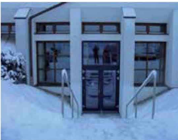
Zwei neue Notausgänge im Gemeindesaal
